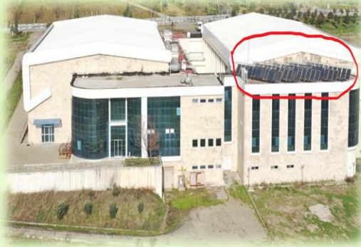
Güneş Kollektörü Örneği – Sıcak su temini amaçlı (MCBÜ Spor Salonu, MCBÜ Kız Yurdu Manisa)
