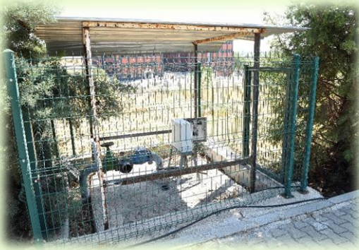
Şekil 5.2 Sondaj pompası ve sondaj kuyusu
