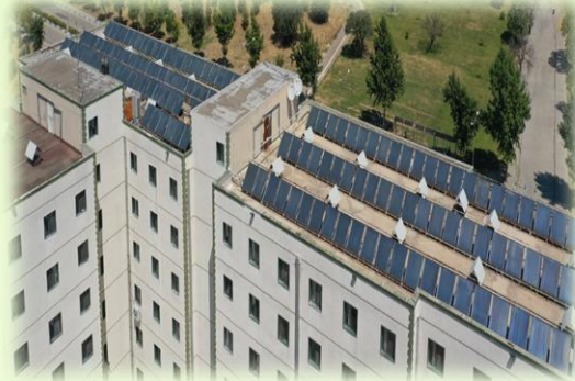
Güneş Kollektörü Örneği – Sıcak su temini amaçlı (MCBÜ Spor Salonu, MCBÜ Kız Yurdu Manisa)
