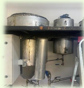
MCBÜ AYDEL (Atık Yağ Değerlendirme Laboratuvarı) Biyodizel Pilot Tesi Şekil 3.3 (b) Kampüste Bulunan Yenilenebilir Enerji Kaynakları
